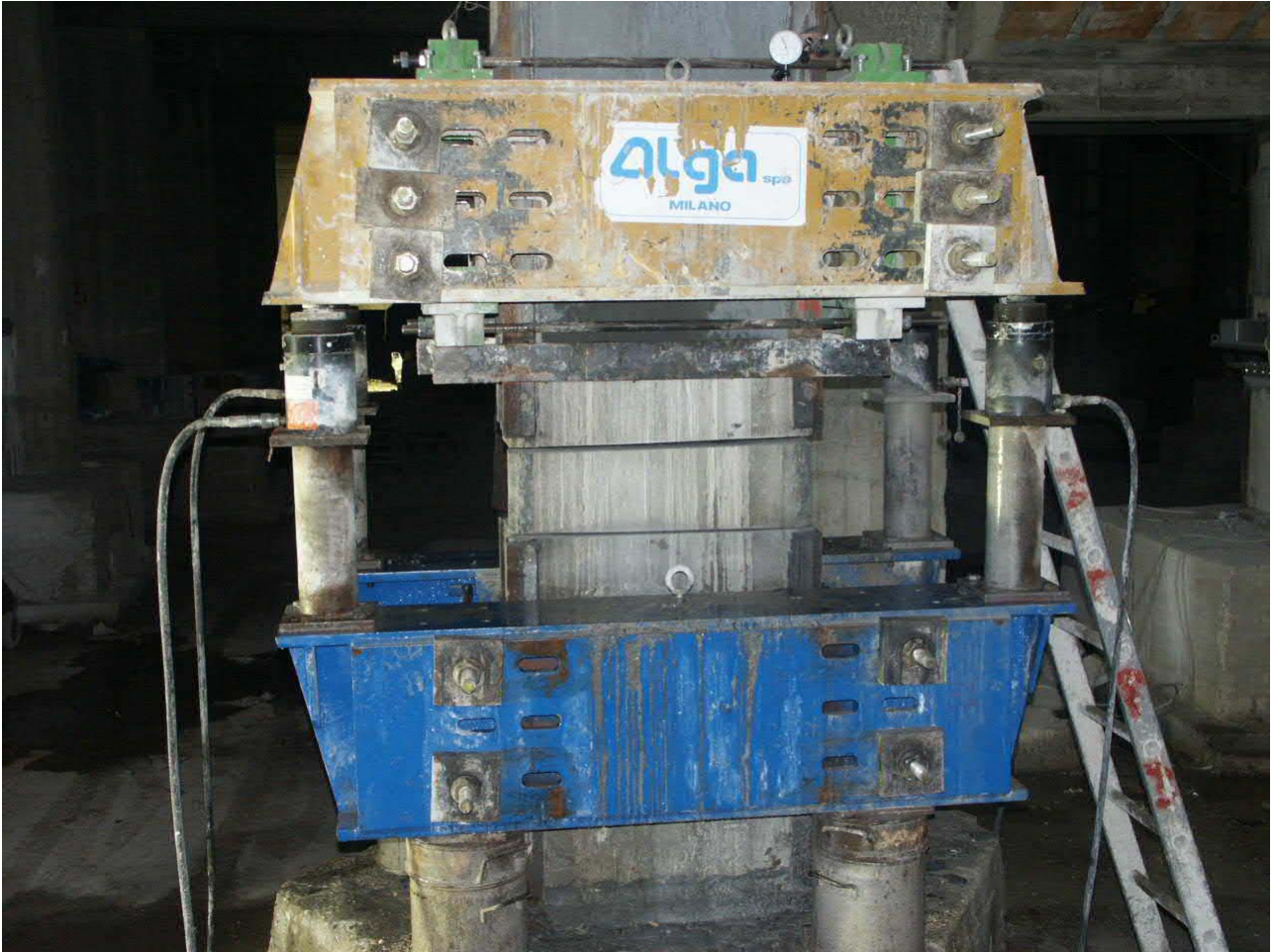
Foto n° 7: attrezzatura ALGA S.p.A. per il taglio ed il supporto dei carichi in fase di inserimento isolatori.
