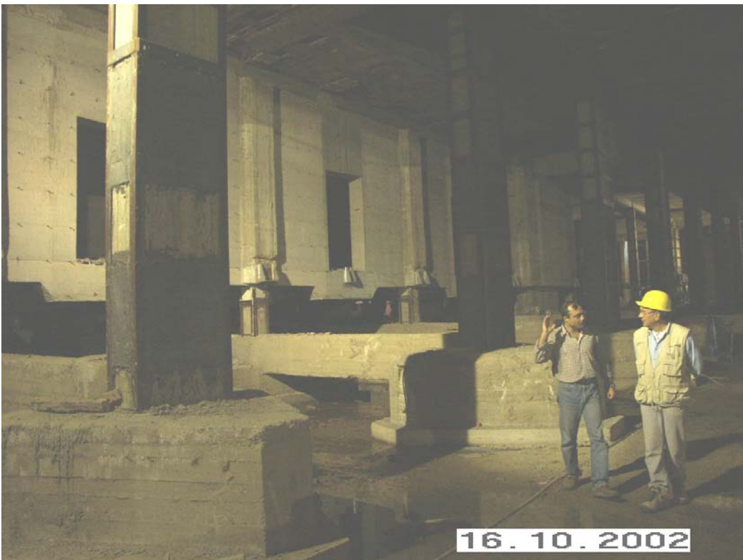
Foto n° 4: Vista di alcune strutture integrative in c.a.
