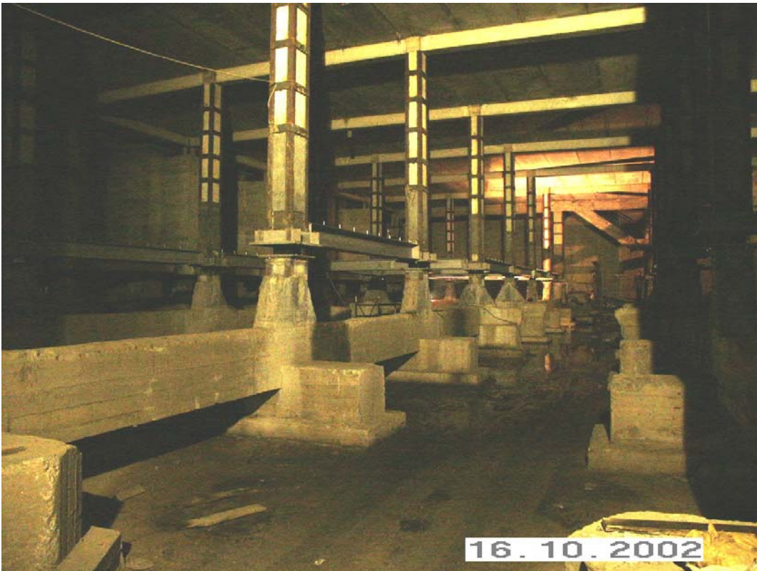
Foto n° 3: Interno a quota del piano di isolamento
