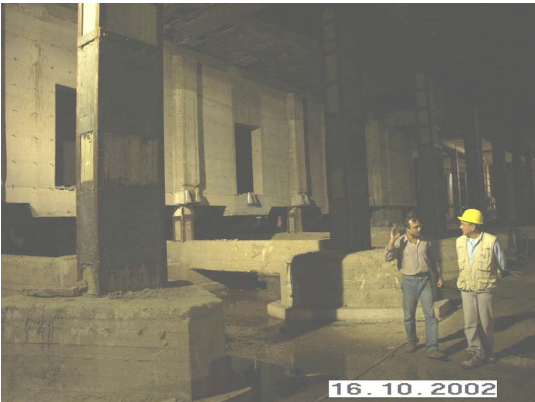
Foto n° 4: Vista di alcune strutture integrative in c.a.
