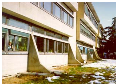
Figura 2: La scuola Johan Heinrich Pestalozzi, costruita a Skopje (Macedonia) negli anni '60 (a sinistra), vista di uno dei LDRB che costituivano sistema d'isolamento sismico originario (al centro) e vista di un nuovo HDRB appena installato nel 2007, a fianco di un LDRB non ancora sostituito (a destra).
