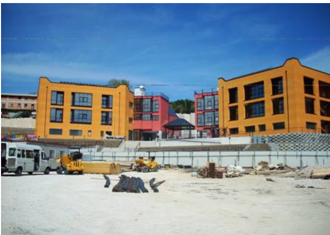
Figura 3: La nuova scuola Francesco Jovine ed il Centro Professionale ed Universitario "Le Tre Torri" di San Giuliano di Puglia, eretti su un'unica piastra isolata sismicamente, al momento dell'inaugurazione il 18 settembre 2008, e vista del sistema d'isolamento sismico durante la costruzione.
