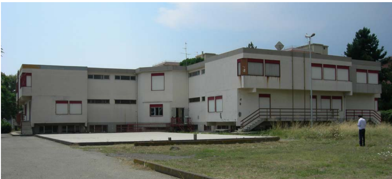
Figura 1. Vista d'insieme della scuola “Quasimodo”
