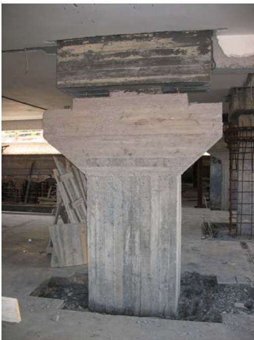
Figura 4. Ringrosso dei pilastri centrali ed inserimento degli isolatori a scorrimento
