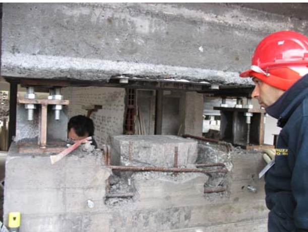
Figura 3. Fasi realizzative preliminari al taglio dei pilastri ed inserimento degli isolatori elastomerici
