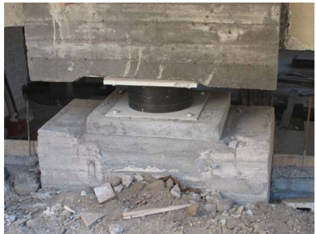
Figura 3. Fasi realizzative preliminari al taglio dei pilastri ed inserimento degli isolatori elastomerici
