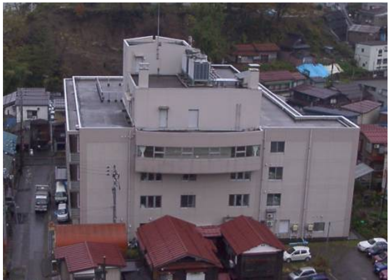
Edificio in cemento armato costruito a Ojiya City nel 1996 (spostamento massimo = 15 cm; spostamento residuo = 3 cm) che ha subito il Terremoto di “Mid Niigata” del 2004 (M=6.8, oltre 40 morti, oltre 2000 feriti)
