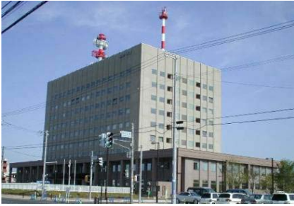
Edificio governativo di 9 piani in c.a. e acciaio con basamento di 1 piano (64 LDRB + 56 LRB + 32 EPD)
