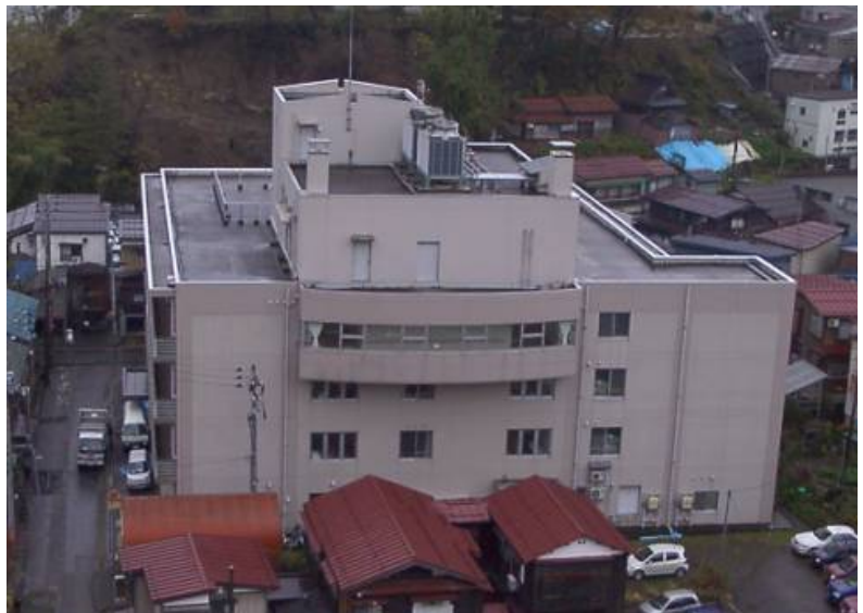
Edificio in cemento armato costruito a Ojiya City nel 1996 (spostamento massimo = 15 cm; spostamento residuo = 3 cm) che ha subito il Terremoto di "Mid Niigata" del 2004 (M=6.8, oltre 40 morti, oltre 2000 feriti)
