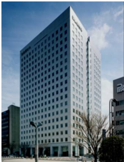
Edificio di 18 piani a Sendai City (primo edificio più alto di 60 m) che ha subito il Terremoto di "Miyagi-Oki" del 2003 (M=7.0, 16 feriti)
