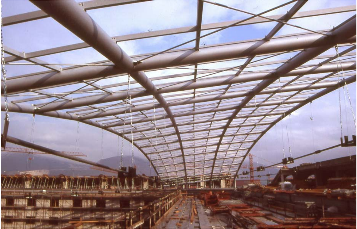
Figura 5: varo del primo settore della copertura avente dimensioni 60x13,50 m (sono visibili le catene provvisorie)
