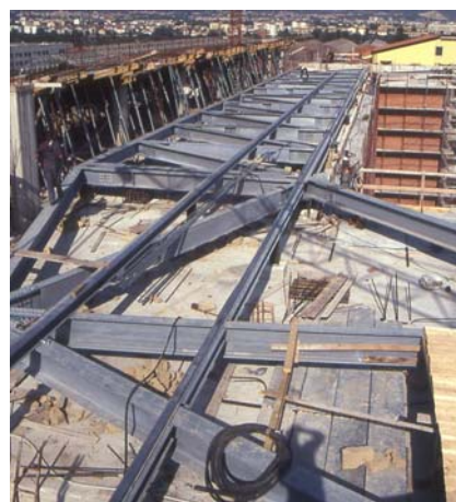
Figura: 4 trave reticolare di bordo
